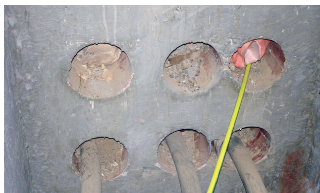
Intérieur du bâtiment Insertion de différents câbles
